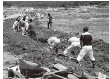
被災した水路の復旧にも支援隊が活躍。
