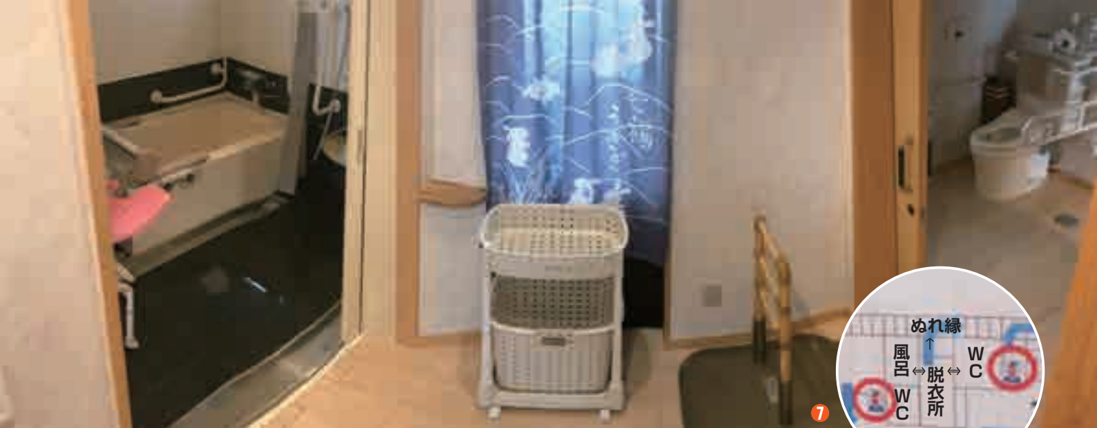
⑦視察先の託老所あんき（松山市）から学んだ浴室—脱衣所—トイレが連続した水回り空間。トイレで失敗した利用者が体面を保つことができ、汚れた衣服をぬれ縁に出せるため臭いがこもらない
