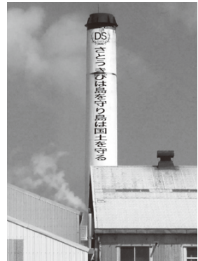
地域経済を支え、国土を守っている南大東島の大東糖業の煙突。 (写真提供:大東糖業株式会社)
